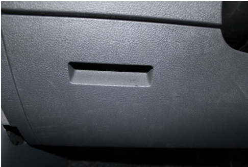
Sicherungskasten (Fahrerseite unten links)
